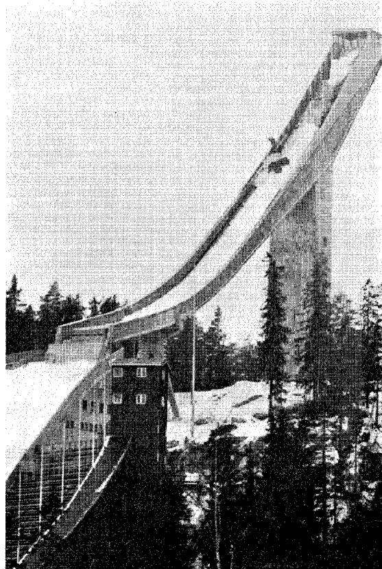
Holmenkollbakken. Utvidelse ferdig 1962. Entreprenør: Astrup & Aubert A/S Rådgivende: E. N. Hylland. Tilsetninger: Betokem P, Betokem HB.
