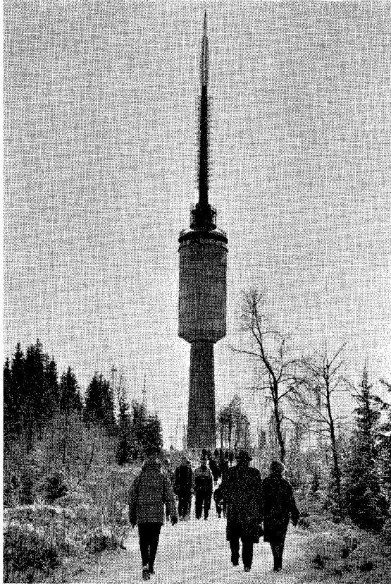
Tryvannstårnet. Entreprenør: Ingeniør F. Selmer A/S Rådgivende: Borring & Rognrud Tilsetninger: Betokem P.
